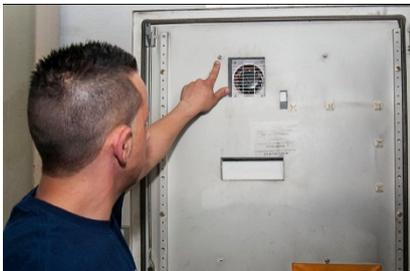
Überprüfen Sie die Dichtung zwischen Kühlgerät und Schaltschrank auf etwaige Schäden. Bei Bedarf ggfs. auswechseln.
